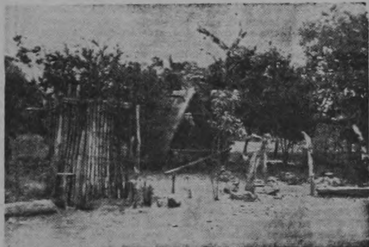
Estas eran las "viviendas" habitadas a la Intemperie y expuestas a toda clase de peligros.
